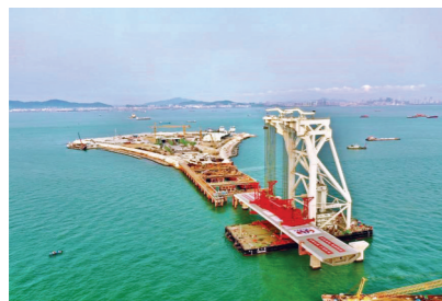
深中大桥大节段整体吊装钢箱梁的施工监控
