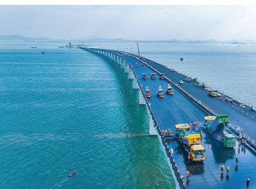
超大规模环氧沥青钢桥面铺装
